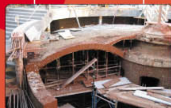
TORINO - UNIVERSITÀ DI GIURISPRUDENZA Taglio Volta ex serbatoio recupero acqua
